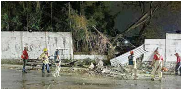
PARTE DE UNA barda colapsó en la avenida Atlacomulco.
