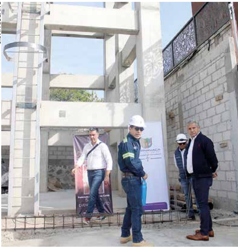
EL ALCALDE JOSÉ Luis Urióstegui supervisó la obra del tanque elevado en la calle Acacias de la colonia Ocotera, que beneficiará a más de cuatro mil familias, según informó el edil.
