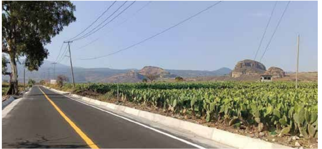
LA REHABILITACIÓN DEL tramo carretero que conduce a San Agustín Amatlipac mejora la conectividad y la actividad productiva en el norte de Morelos, subrayó la dependencia.
